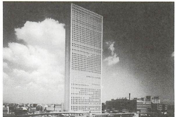
えても梁の断面寸法は、ピン接合の場合と殆ど変わりません。ラーメン型、チューブ型というのは構造モデルとしての概念的な区別で、モデル化することにより骨組解析の計算量を減らすことが出来ますが、コンピュータの計算容量が飛躍的に増大した今日では、より複雑な骨組の力学解析が出来るようになったので、この区別はあまり意識されていません。
