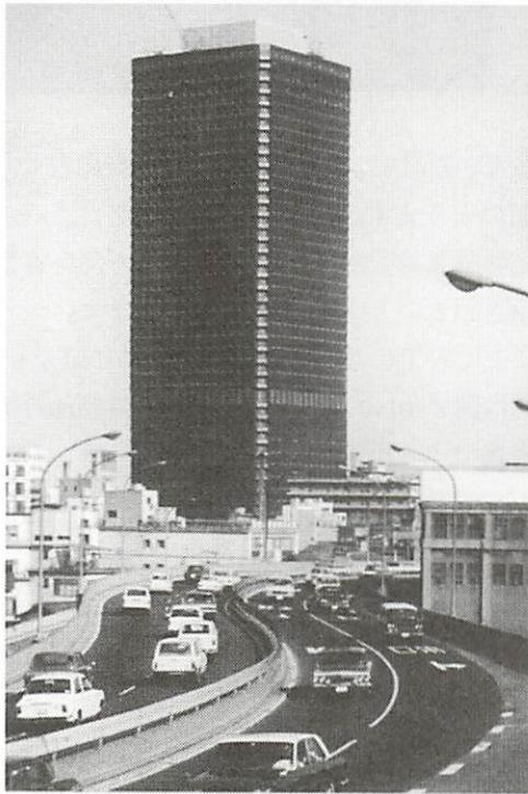
松町駅前にある名前も同じ「世界貿易センタービル」でWTCのすぐ後で建設されたものです。規模が小さいだけでWTCと殆ど同じ構造形式です。その後新宿、池袋等に多くの高層ビルが建設されましたが、敷地条件、平面計画上の要求から正方形平面ではなく、長方形、その他の平面形のもので設計されています。図5は池袋のサンシャインビルです。この場合はラーメンとチューブの折衷形になっており、床梁と外周柱は剛接合(曲げモーメントを伝える接合)になっていますが、このような長スパン梁では断面のサイズは鉛直荷重による曲げモーメントで決まりますので、ラーメン効果を考
